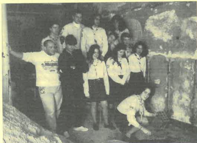
Lançamento da «1.ª Pedra» nas Obras de restauração da antiga Igreja do Seixal.
